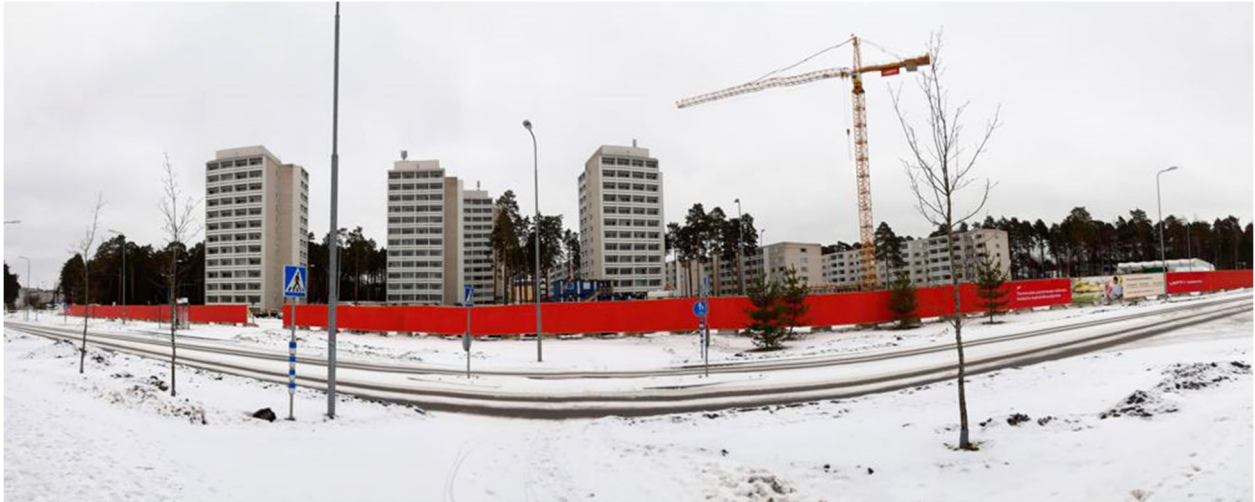
Kuva: Kaava-alueen eteläosan työmaa Sairaalanrinteen varressa alkuvuodesta 2020.
